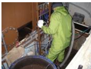
汚泥引き抜き作業
